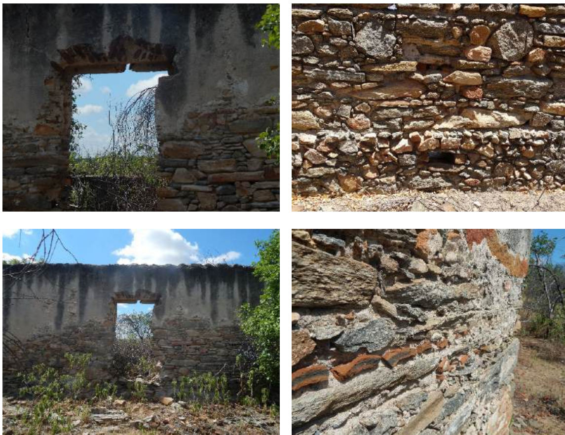
Figura 11 – Imagens destacando o estilo construtivo da casa sede, evidenciando os tipos de materiais presentes
