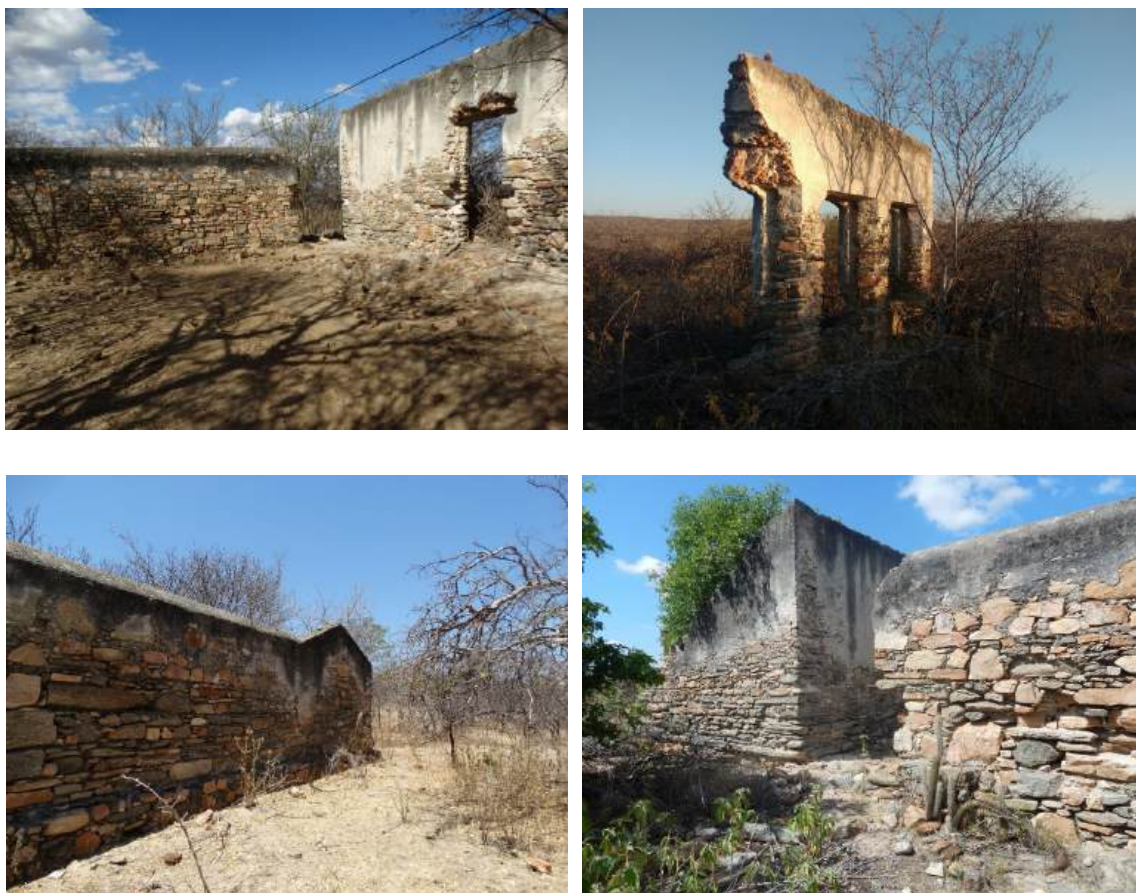
Figura 01 – Estruturas da casa sede do sítio Culumins, as paredes correspondem a parte da frente e aquelas da porção final da edificação
